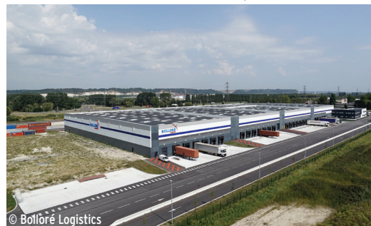
Le nouvel hub multimodal de Bolloré Logistics dans le PLPN2
